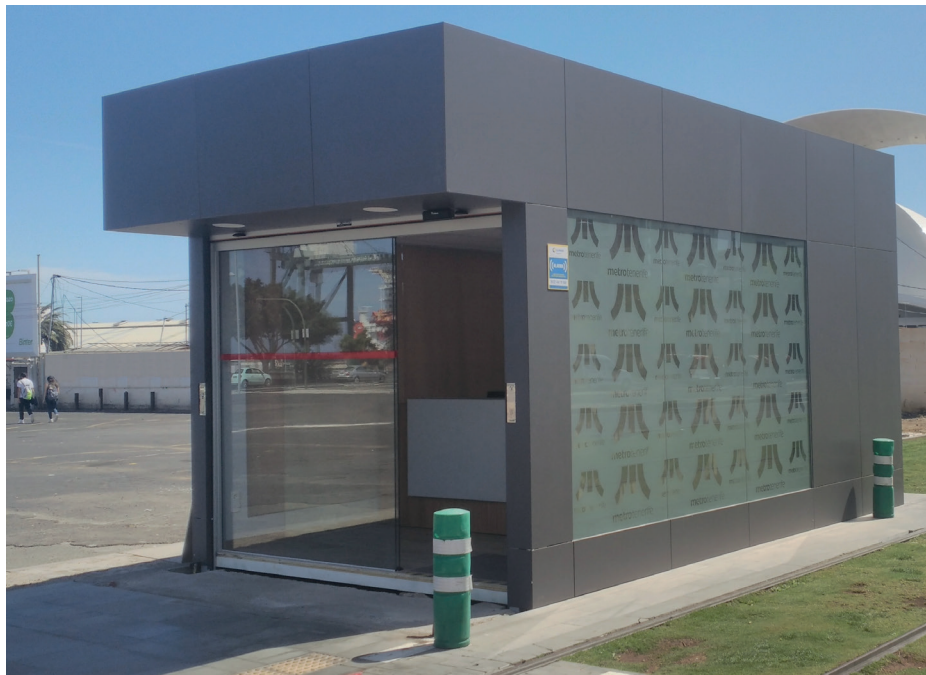
Las nuevas oficinas, más diáfnas y accesibles, mantienen su ubicación en las paradas Intercambiador de Santa Cruz y La Trinidad, en ambos extremos de la Línea 1.
