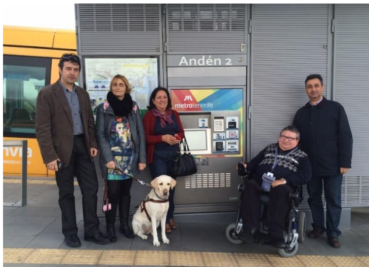
Visita de trabajo, junto a representantes de diversos colectivos (ONCE, Queremos Movernos y Coordinadora de Personas con Discapacidad Física en Canarias, a la expendedora prototipo instalada en la parada de las Mantecas.
