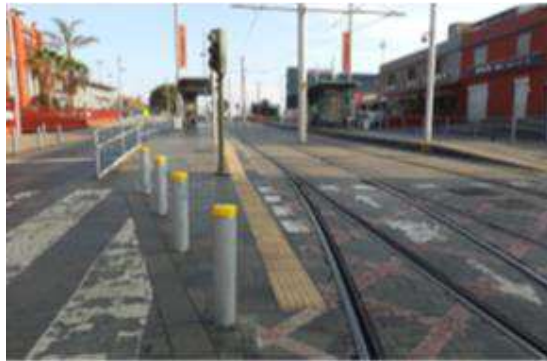
Pivotes pintados de amarillo en la parte superior como nueva medida de accesibilidad en la parada de El Cardonal
