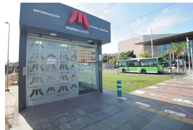
Oficina comercial del Tranvía de Tenerife en la actualidad, en la parada Intercambiador, en Santa Cruz de Tenerife, sin obstáculos para la accesibilidad en su entrada
