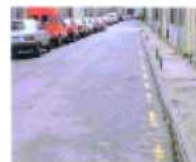
Marca amarilla longitudinal discontinua
